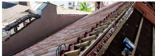
Telhas fotovoltaicas em cor terracota em Évora. Fonte:cm.evora.pt
